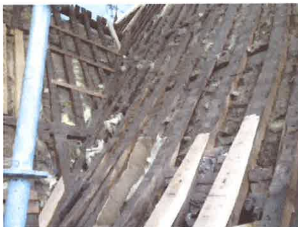
Zone de la charpente du bâtiment E de l'Aile Sud, traitée après la découverte.
